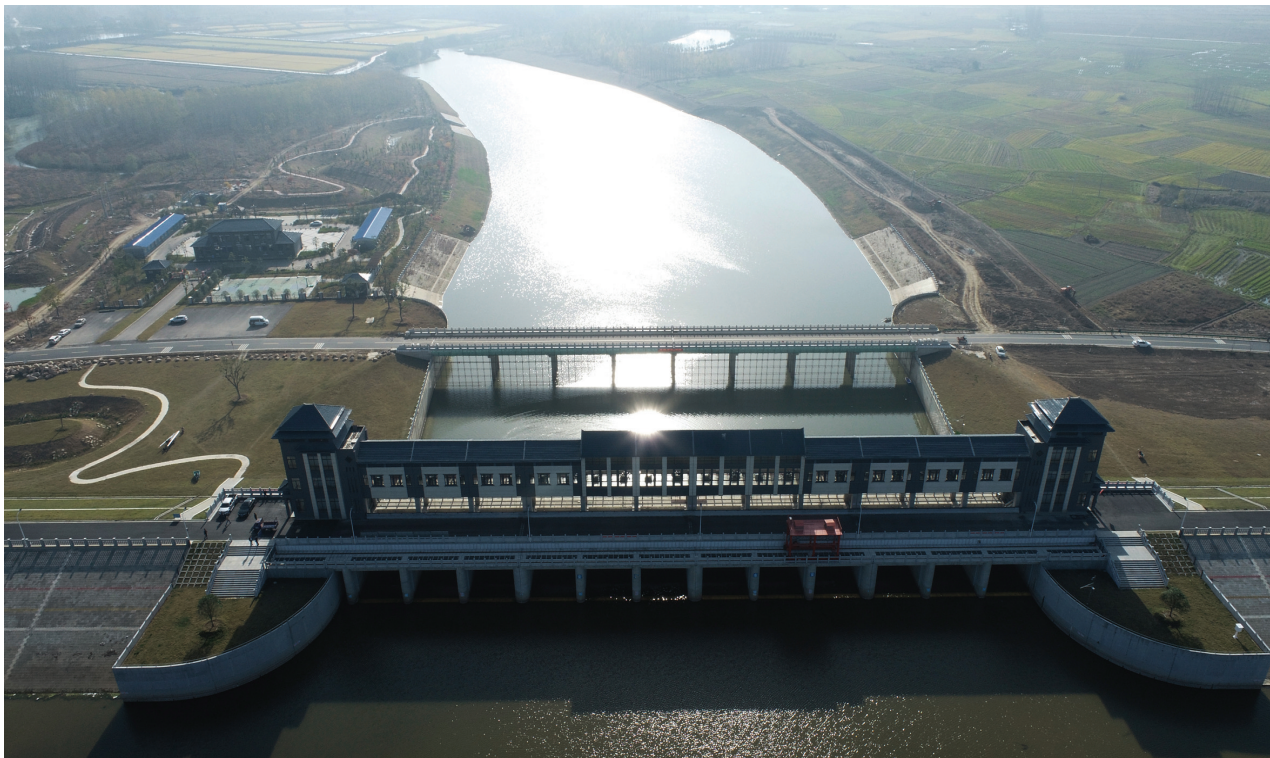
图为江巷水库大坝 吴家保摄
