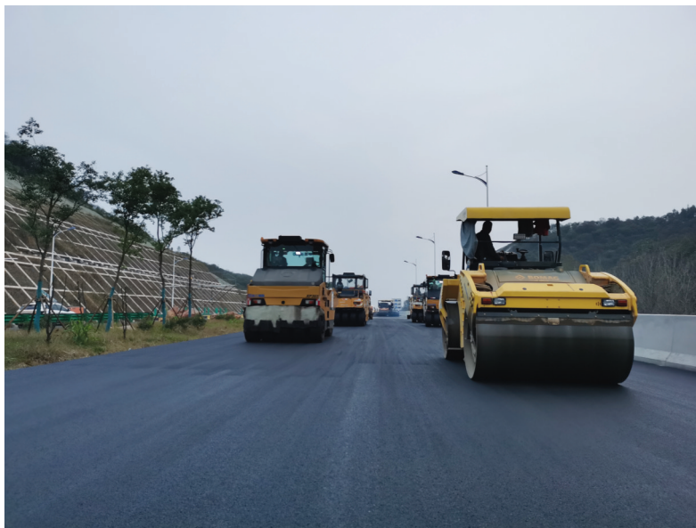
图为施工现场。
