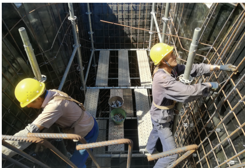
施工人员在墩身井内绑扎钢筋。
