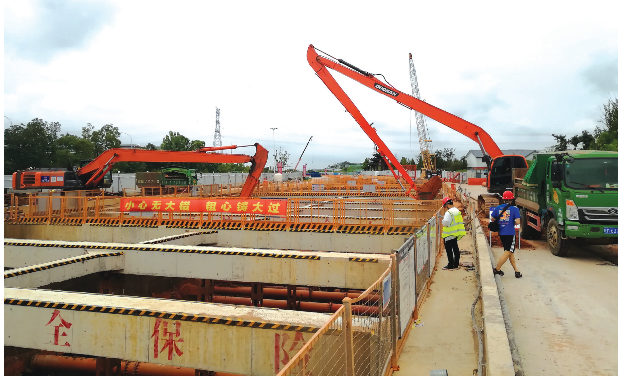
图为城际铁路基坑挖掘现场。
