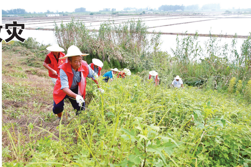
7月20日，在南谯区乌衣镇，吕赵社区志愿者在蒿子圩堤坝上进行清障，巡堤查险，确保堤坝安全。记者卢志永 通讯员李永斌 摄
