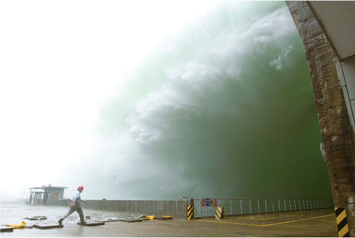
新安江电厂工作人员从正在泄洪的新安江水库坝底经过。
