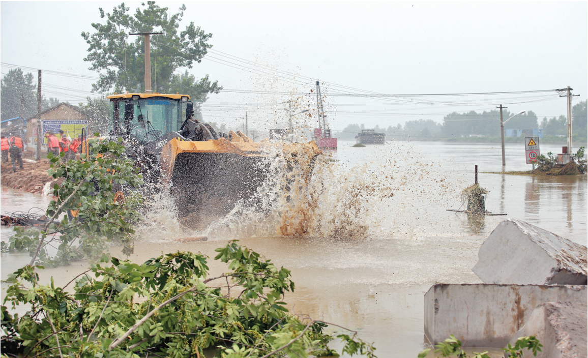
昨日,滁河全椒古河段古河大桥鸿运码头,救援人员利用大型机械封堵加固堤坝。 记者卢志永 计成军摄
