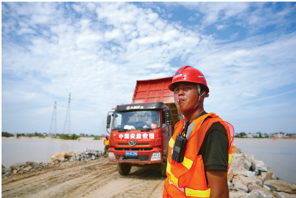
7月12日,工作人员在问桂道圩堤施工现场调度车辆。
