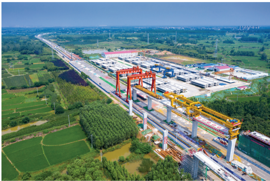
滁宁城际铁路首梁架设现场。 武玉宏 陶舒媛 摄
