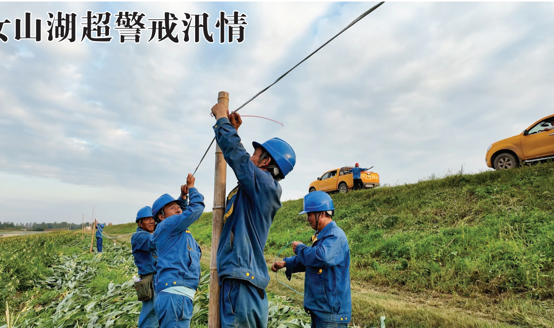
▲供电部门组织人员架设临时线路。
