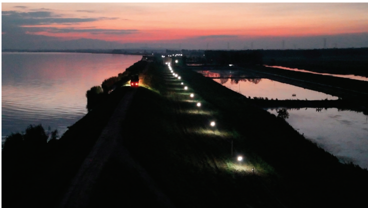
夜间照明灯,为夜间巡堤查险提供保障。
