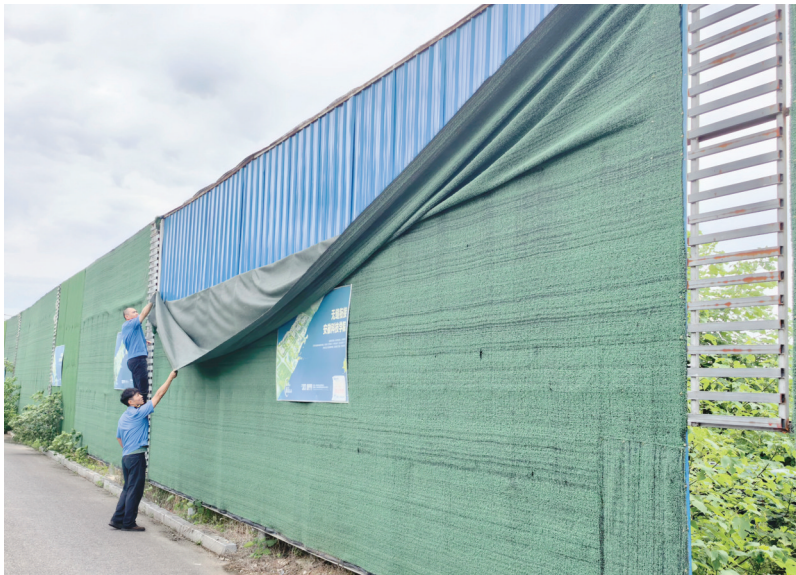
台风“白海豚”预警信息发布后,南谯新区城管第一时间响应,全面开展户外广告设施防风安全专项排查整治工作,细致核查设施材质、钢架结构、固定牢固度及日常管护情况,做到隐患早发现、早处置。
