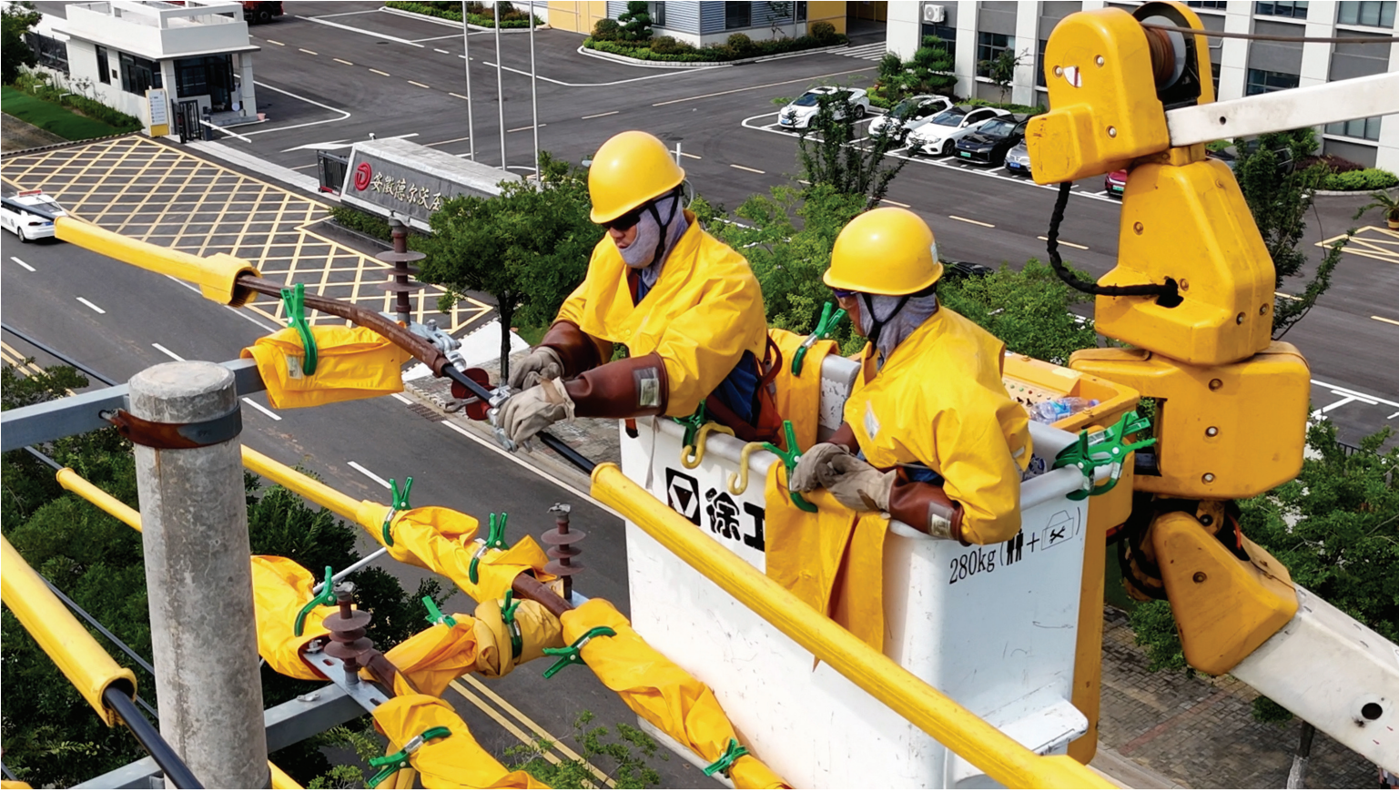
7月28日,在明光经济开发区主供线路10千伏华远134线上身着厚重绝缘屏蔽服的电力工人正在开展检修消缺工作。盛夏时节,热浪升腾。明光市迎峰度夏保供电进入关键时期。国网明光市供电公司以带电检修、故障恢复、零感知作业为抓手,全力保障电网安全平稳运行,用汗水守护万家清凉。
