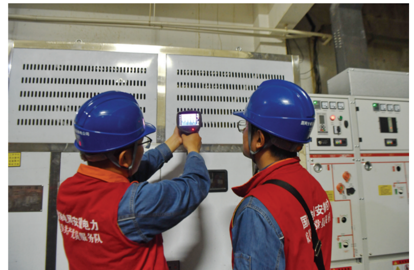
5月10日,国网全椒县供电公司组织党员服务队对高考考点地下配电房进行红外测温、特巡特护,全力保障高考期间供电可靠。陈雨昕摄
