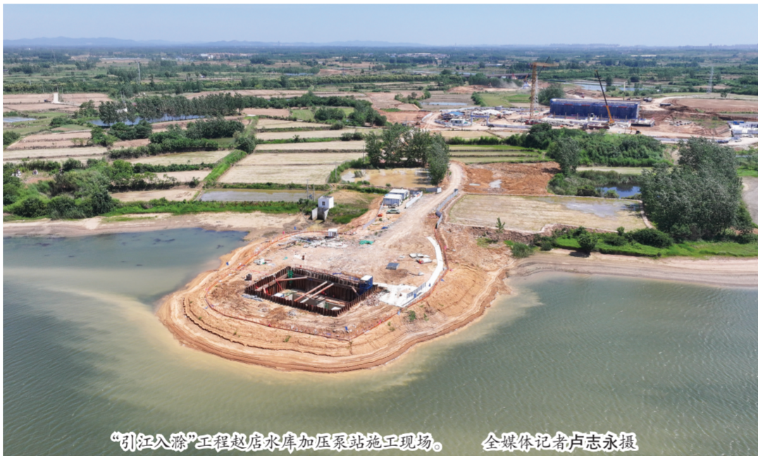
“引江入滁”工程赵店水库加压泵站施工现场。全媒体记者卢志永摄
