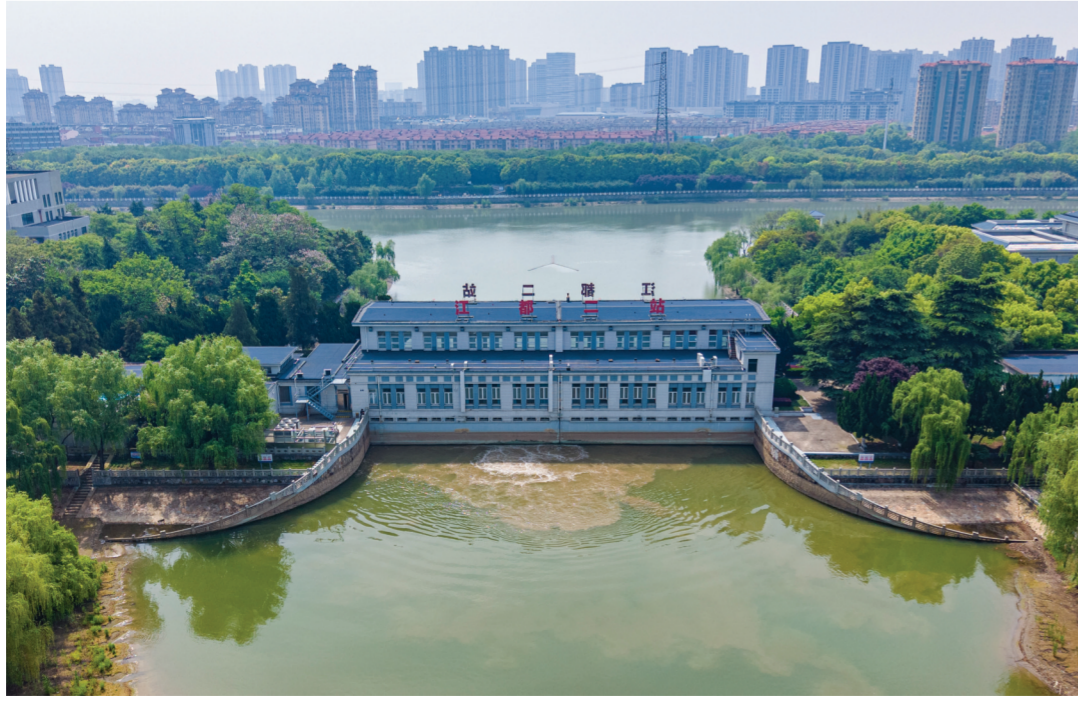
4月27日,位于江苏省扬州市江都区的南水北调东线源头江都水利枢纽二站启动调水(无人机照片)。4月27日10时,根据南水北调东线一期工程2026年4月水量调度方案,江苏省江都水利枢纽工程管理处启动新一轮调水,南水北调东线应站同步启动调水。新华社发
