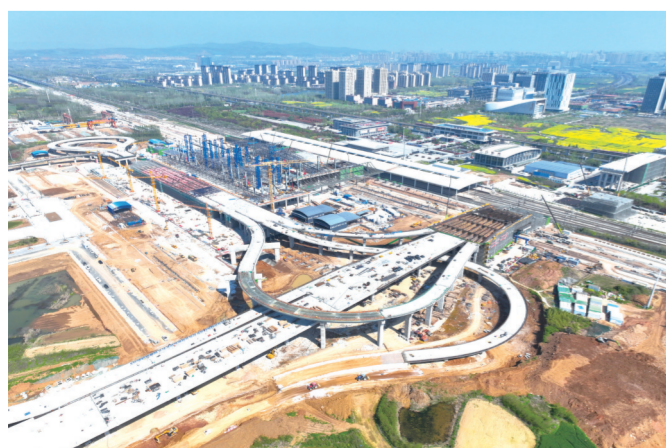
▲北沿江高铁滁州站施工现场。
