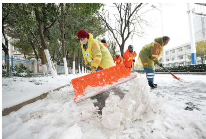
▶1月20日,市政工人在清除桥梁面积雪。 全媒体记者卢志永摄
