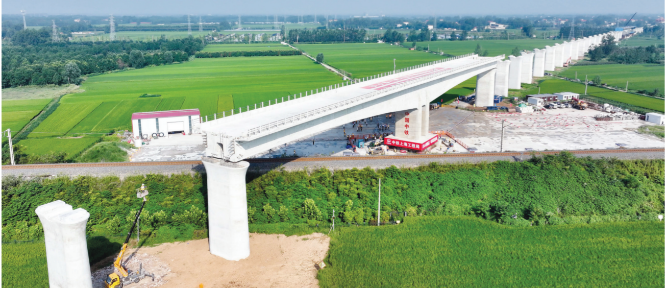
8月28日,中铁上海局的工作人员在进行潍宿高铁郑城浞河特大桥上跨胶新铁路T构梁转体作业(无人机照片)。潍(坊)宿(迁)高铁郑城浞河特大桥上跨胶(州)新(沂)铁路T构梁顺利完成转体作业,为后续箱梁架设打下了坚实基础。据悉,潍宿高铁是京沪高铁辅助通道的重要组成部分。新华社记者郭绪雷摄
