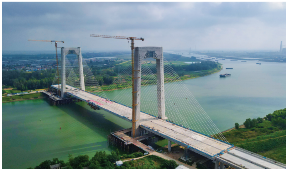
图为临淮关跨淮河特大桥主桥“合龙”。
