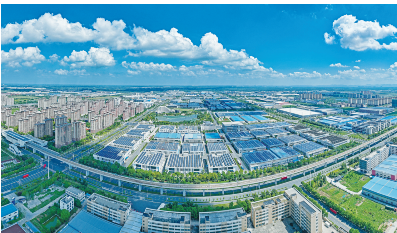
现代化厂房鳞次栉比的中新苏滁高新区。
