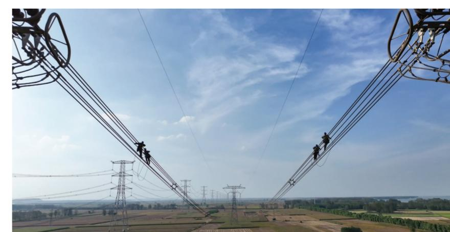
国庆假期,国网滁州供电公司运检中心工作人员按年度计划对800千伏山西雁门关至江苏淮安特高压直流输电线路进行综合检修,消除线路运行各类缺陷,保障特高压大动脉安全稳定运行。
