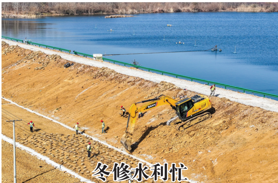
日前,在琅琊区三官街道老虎庄水库项目工地,工人们在加紧施工。今年以来,琅琊区把做好惠民水利工程作为提高农业综合生产能力、支撑三农发展的重要因素,投资2760万元实施11座水库除险加固工程,提升水库防洪保安全能力。特约摄影杨毅摄
