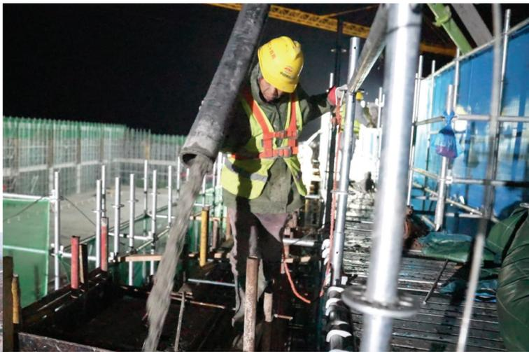
近日,在明光市明西街道西徐村明光西站施工现场,随着最后一方混凝土浇筑完成,标志着新建合肥至新沂高铁明光西站站房混凝土主体结构全面封顶,项目建设进入钢结构及装饰装修阶段。明光西站站房主体为两层,局部设置夹层,建筑面积12000平方米,建筑高度24米,为线侧平式站房,站场规模为两台四线,最高聚集人数达800人,采用“上进下出”的旅客流线方式,旅客出站通过出站地道至架空层出站厅与地面配套设施衔接。
