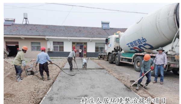
村庄人居环境整治提升项目
