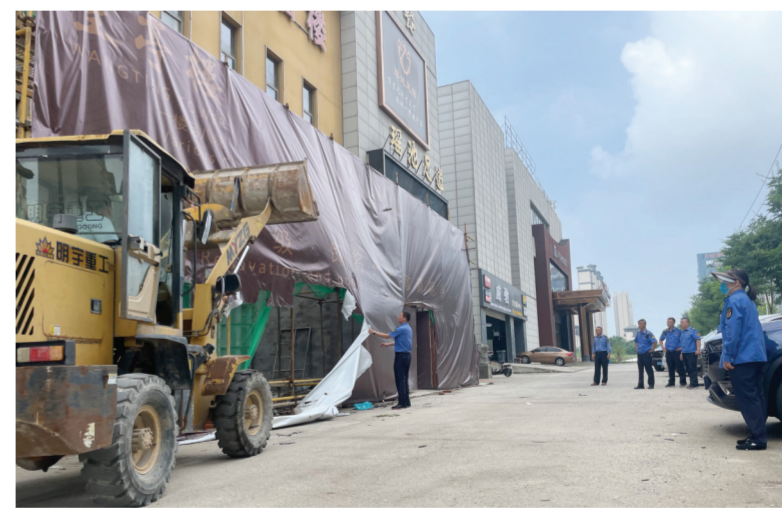
6月20日,南澳区城管执法局对居然之家一门面擅自外扩增大经营面积的违建进行拆除。此举有效打击违建行为,遏制跟风效仿,大大维护了城市外立面整洁美观。董超 杨红晖摄
