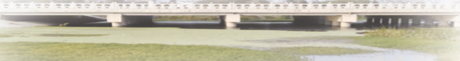
沙岗水库大堤看淮西路大桥
