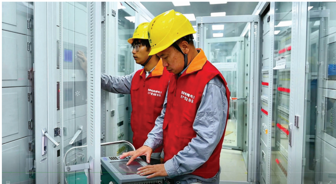
供电公司员工对机房进行检修,确保线路安全。
