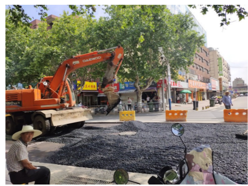
地下工作结束后，很快将道路恢复原状。
