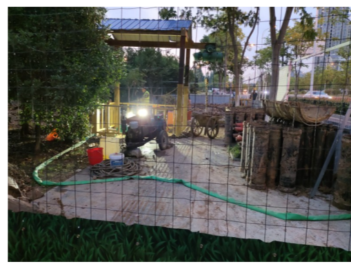
连续24小时施工。
