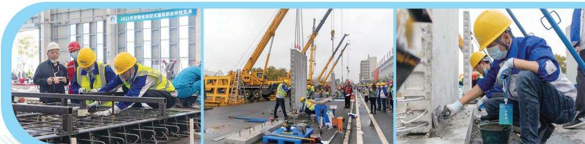
实操环节工序：构件制作、构件装配、灌浆
