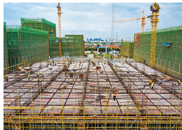
正在施工建设中的浦口-南谏合作标准化厂房一期项目。
