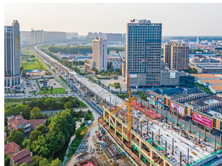
正在建设中的滁宁城际铁路来安县汉河新区段。
