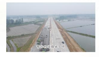
8月高温来袭,在石沛镇农村公路提质改造工程建设 现场,施工人员头戴安全帽,冒着酷暑、挥汗如雨、紧张忙 碌,多台施工机械开足马力、运行不停,摊铺沥青路面…… 洒水车辆来回不停配合降尘,一派繁忙有序、高质高效的施
