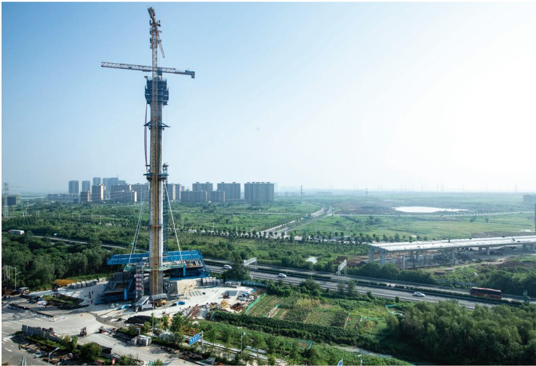
8月1日上午8时18分,随着主桥主塔塔柱第二十六节混凝土浇筑完毕,明光市嘉山大道跨宁洛高速上跨桥项目主桥主塔正式封顶。
