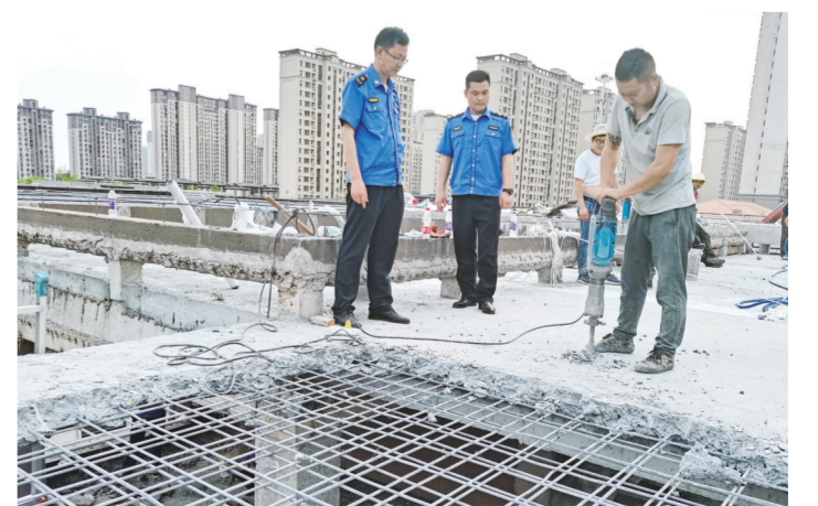
近日,南谯城管执法人员克服高空作业困难,对某小区楼顶违法建设依法进行拆除,以有效打击违法建设嚣张气焰,遏制违建跟风蔓延势头。 董超 杨红晖摄
