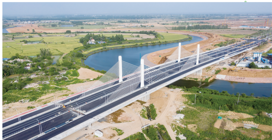
滁州大道跨清流河桥
