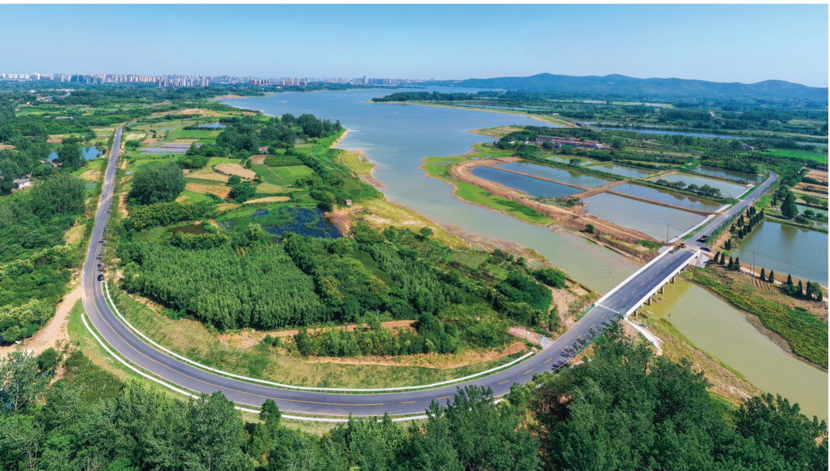
西涧湖环湖道路整治工程是我市重点工程,旨在加强对西涧湖的保护,确保滁城居民饮水安全。该项目起终点均设置在世纪大道与滁定路交叉口西,闭合成环线。于2020年2月28日开工,全长约18.937公里,分A、B、C、D四个路段。A段新建段为主体工程,长9.718公里,主体及绿化工程已完工并通车。图为6月5日拍摄的已建成通车的A段环湖路和西涧湖景色。全媒体记者卢志永 通讯员唐封凯摄
