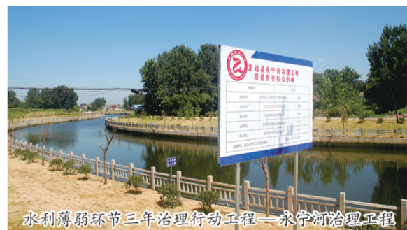
水利薄弱环节三年治理行动工程——永宁河治理工程
