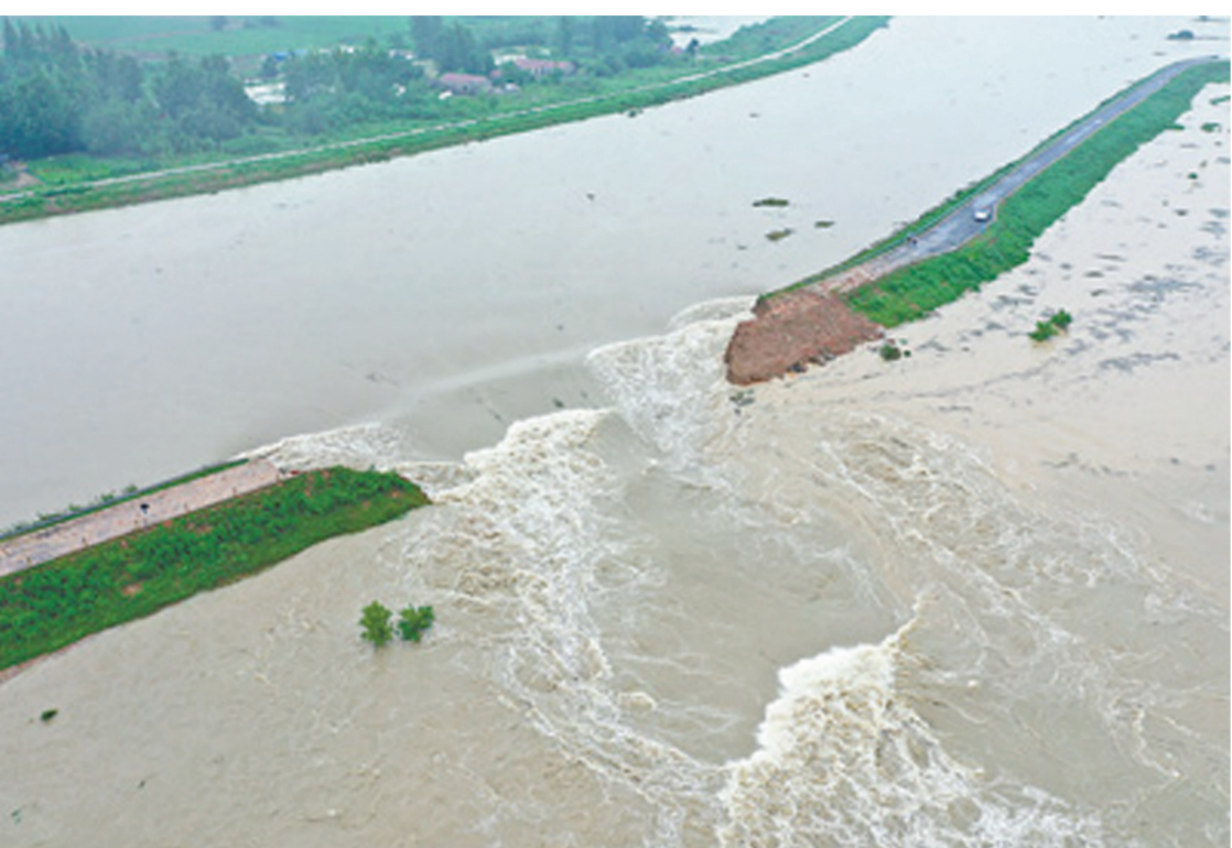
为缓解防洪压力，7月19日凌晨，全椒县对滁河两处坝堤实施爆破泄洪。凌晨2点49分，荒草三圩滁河坝堤被精准炸开一个巨大缺口，洪水涌入蓄滞洪区；凌晨3点27分，荒草二圩成功爆破。图为荒草二圩泄洪口。
