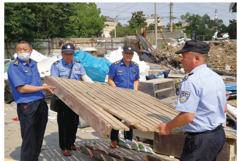
5月27日，南谯区城管执法人员在紫南社区拆除违建。今年以来，该社区不断加大违建整治力度，为创建全国文明城市工作保驾护航。（徐海东 杨读俊摄）
