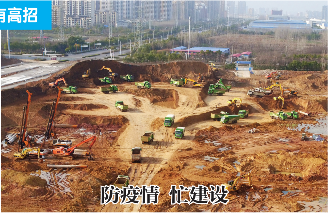
2月23日,南谯区敬梓路与金陵路交叉口东北侧的万桥西苑安置房工程建设现场,数十辆工程车辆忙着清运土方。连日来,我市推出多项硬核措施,帮助企业解决实际困难,确保在建工程有序复工,实现防疫安全与复工安全“两手抓、两促进”。
